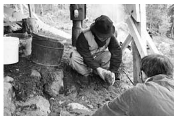
山小屋の土台作り
